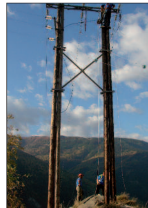
Dépose de ligne aérienne
