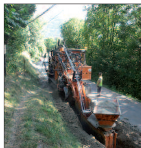
Enfouissement des réseaux
